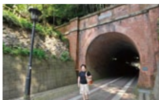
北吸トンネル
